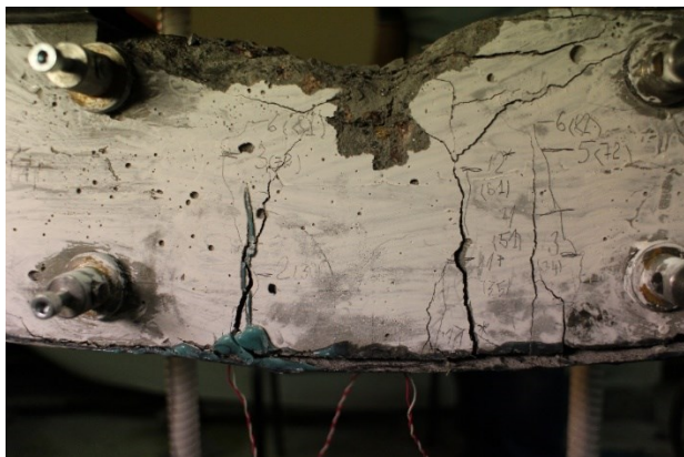
Рис. 10. Общий характер разрушения образцов, внешне армированных углепластиком
